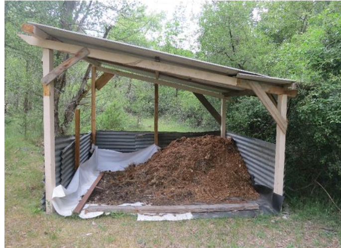
Exemple d'aire de compostage conforme
