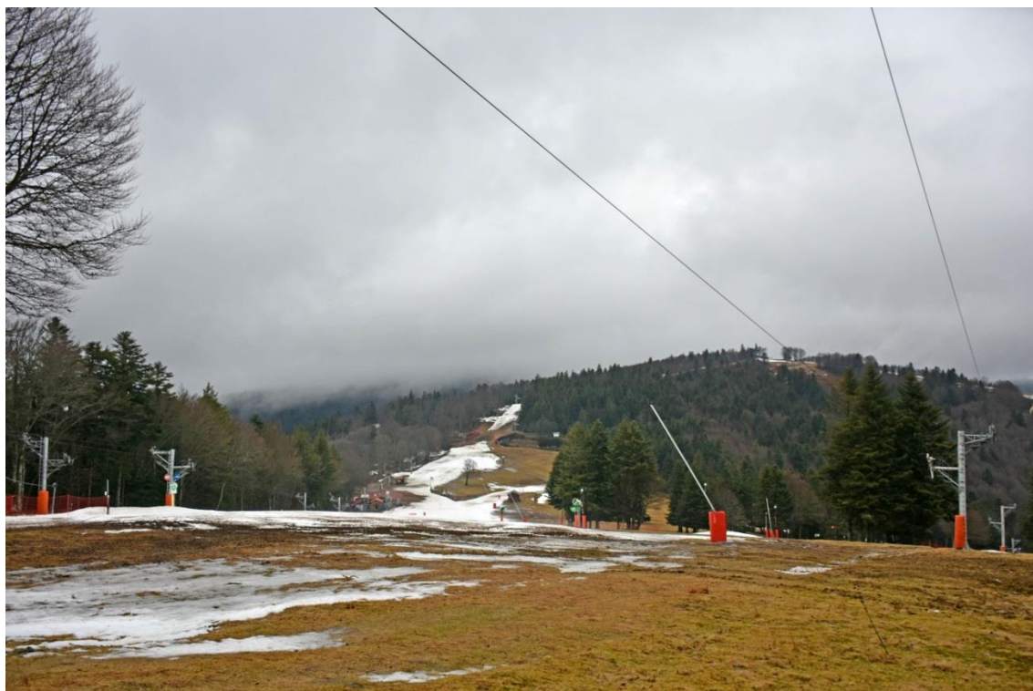
Infrastructures et équipements déjà présents sur le site de la Gentiane (photo AUTB, février 2020).
