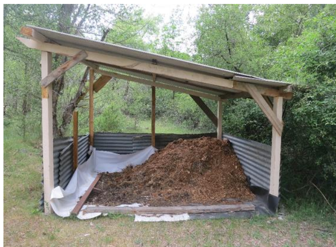
Exemple d'aire de compostage conforme
