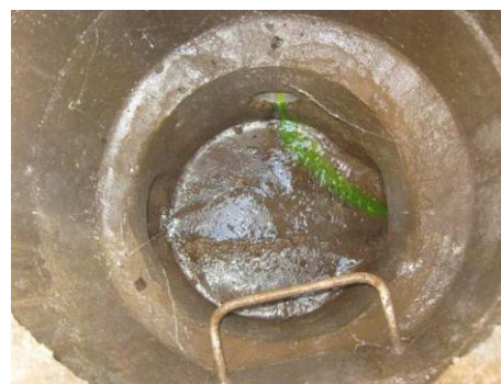
Validation de la connexion hydraulique à l'aide de colorant
