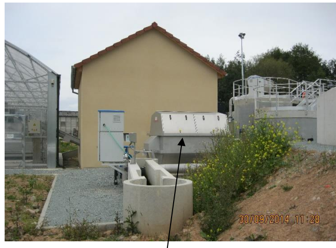
Filtration de la station d'Anjouley
