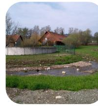
Canalisé sous la station d'épuration de Giromagny lors des travaux de construction de cette dernière, le ruisseau de la Siotte présentait une continuité écologique entravée sur environ 115 m linéaires. En 2018, la CCVS a réalisé des travaux de remise à ciel ouvert pour restaurer ce ruisseau en créant un bras de contournement.
