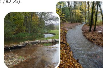
Une rectification ancienne du lit du Rhône, couplée à l'implantation d'un seuil d'alimentation d'un étang, est à l'origine d'un débordement du cours d'eau à Auxelles-Bas.
