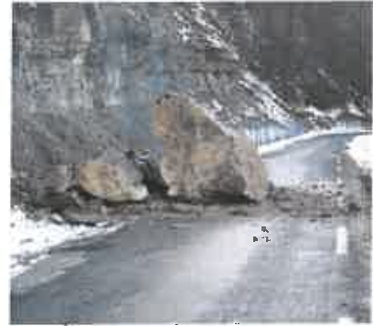
Éboulement d'un rocher le 02/12/2009, Plaimbois-(25) – (Source gendarmerie)
