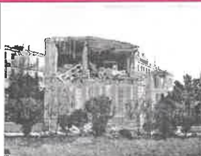
Destruction de bâtiments à Menton (06) suite au séisme de 1887 et à la liquéfaction des sols (Source : Les Tremblements de Terre - FA Fouqué)
